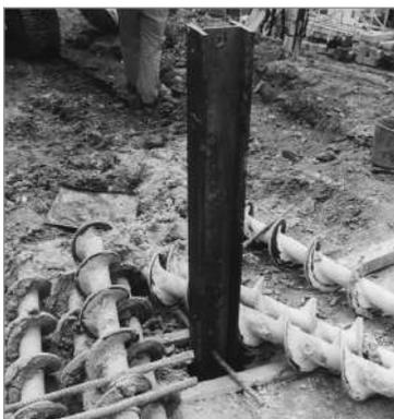
Figura 6.4 Perfil metálico introduzido em furo previamente executado
