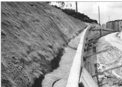
Figura 8.4 Talude pregado junto a parede tipo Munique
