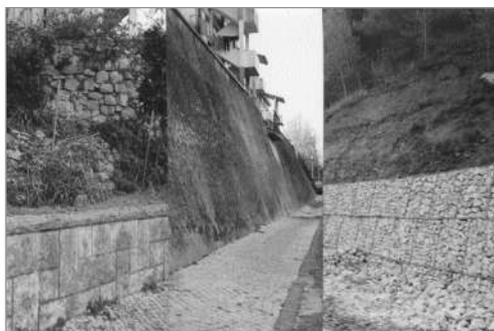
Figura 14.1 Muros de alvenaria de pedra ordinária seca e aparelhada argamassada
