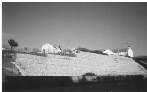
Figura 14.3 Dois exemplos da utilização de gabiões, junto a obras rodoviárias
